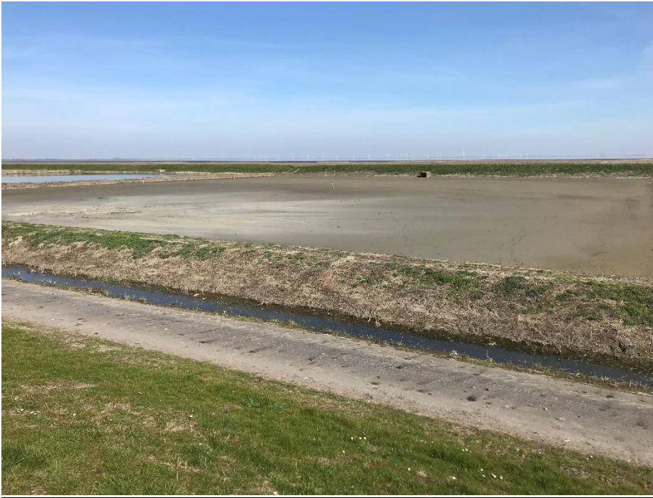
Fig. 9 Aanzicht vanaf dijkzijde
