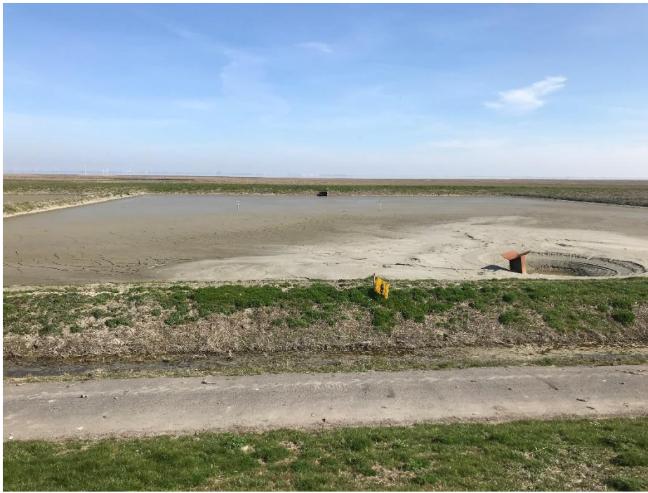
Fig. 17 Aanzicht vanaf dijkzijde
