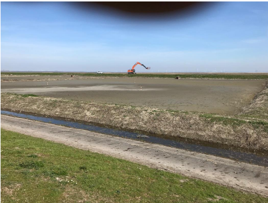
Fig. 12 Aanzicht vanaf dijkzijde
