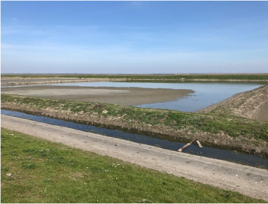
Fig. 7 Aanzicht vanaf dijkzijde
