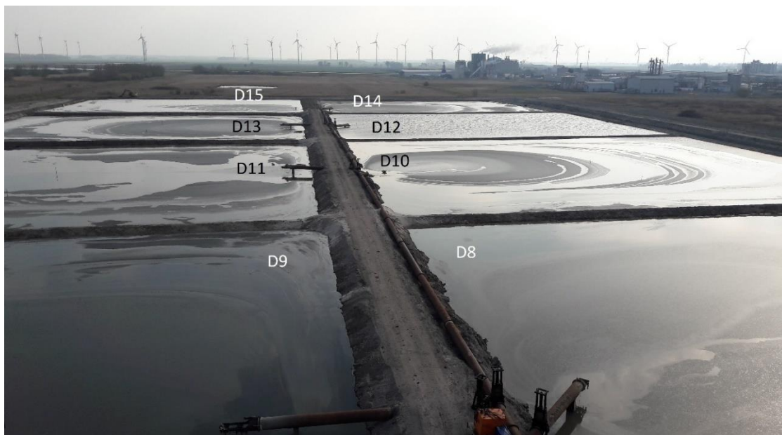
Foto 4.4: Vakken D8 t/m D15 vlak na de eerste vulslag bij Kleirijperij Delfzijl
