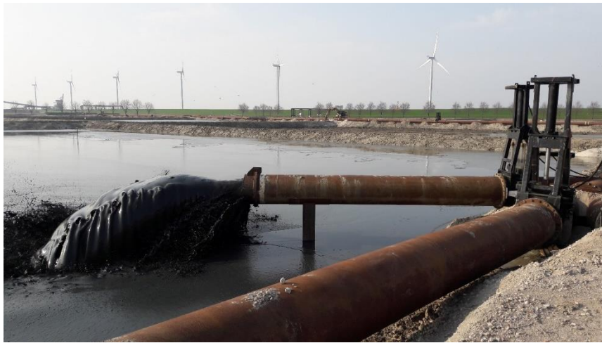
Foto 4.2: Vulslag 1 Kleirijperij Delfzijl – 10 april 2018, proefvak D8
