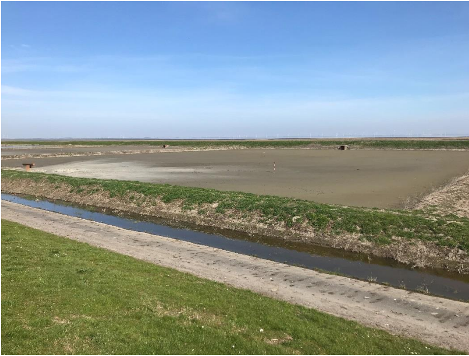
Fig. 11 Aanzicht vanaf dijkzijde
