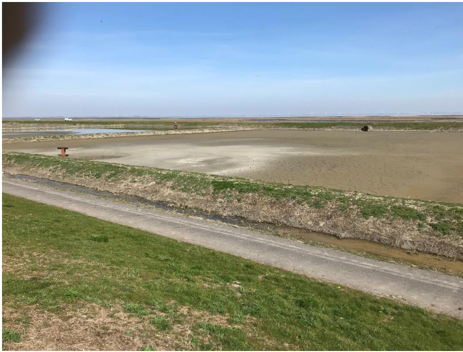
Fig. 15 Aanzicht vanaf dijkzijde
