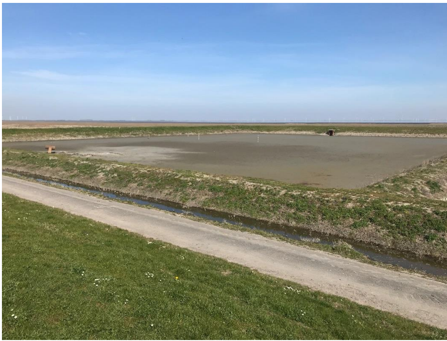
Fig. 2 Aanzicht vanaf dijkzijde
