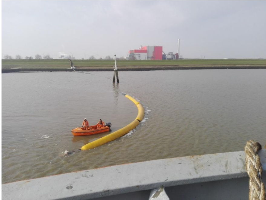
Foto 3.2: Slibvervoer van de sleephopperzuiger naar de Kleirijperij locatie Delfzijl – 9 april 2018
