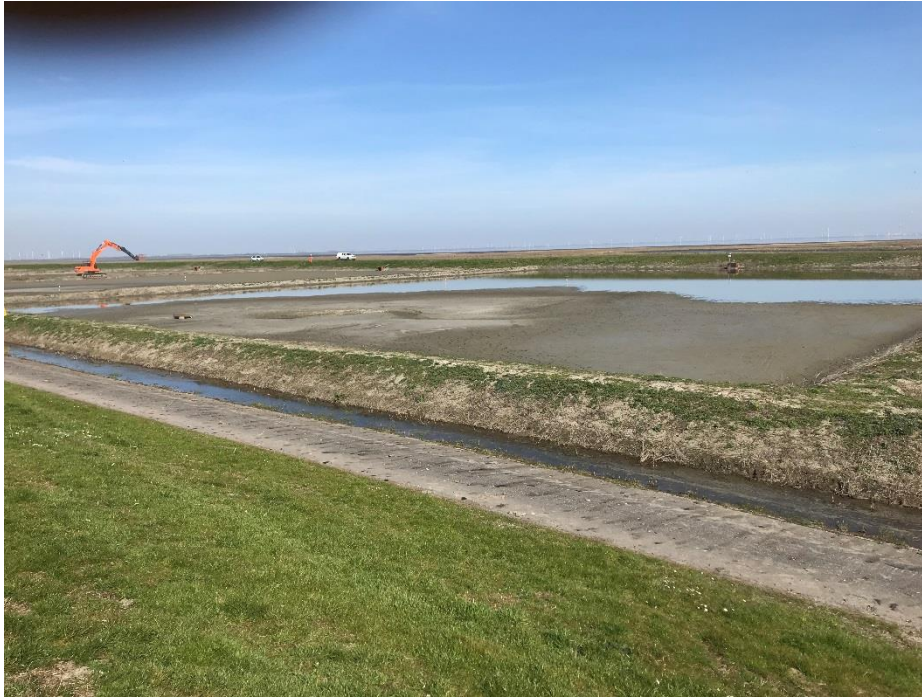
Fig. 13 Aanzicht vanaf dijkzijde
