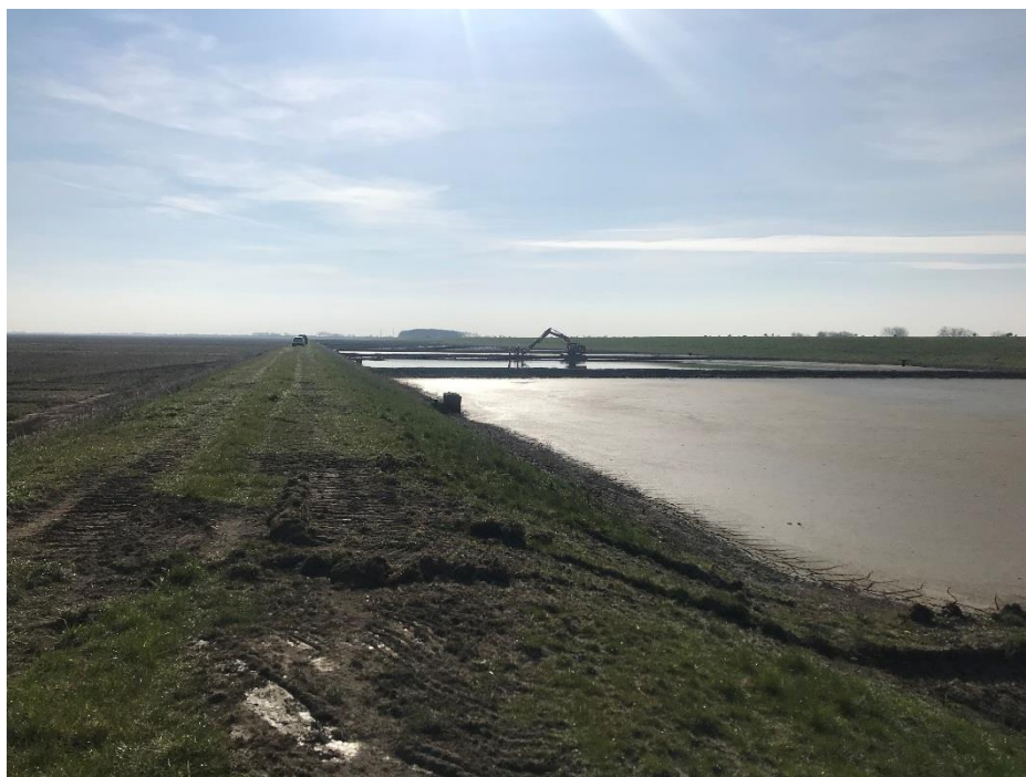
Fig. 4 Vak 2 Aanzicht vanaf noordzijde
